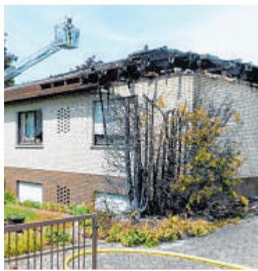
Schwer beschädigt wurde dieses Haus in Minden. FOTO: POLIZEI
